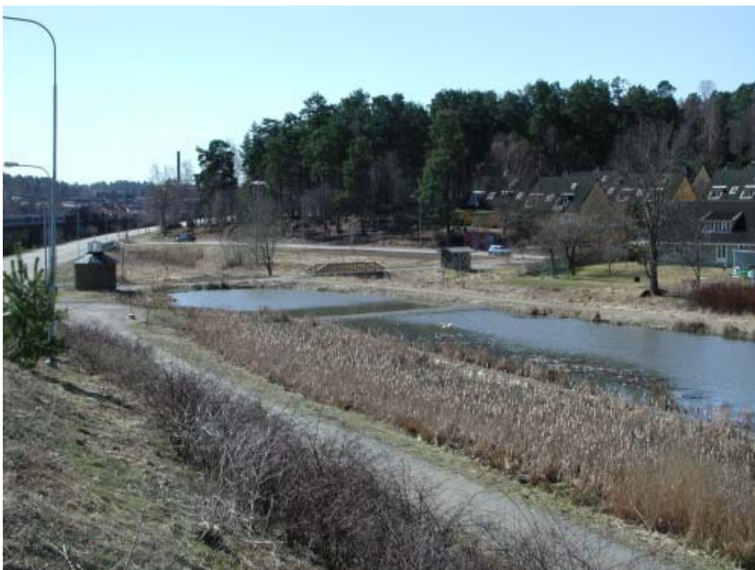
Ladbrodammen med översilningsyta, Upplands Väsby kommun .
