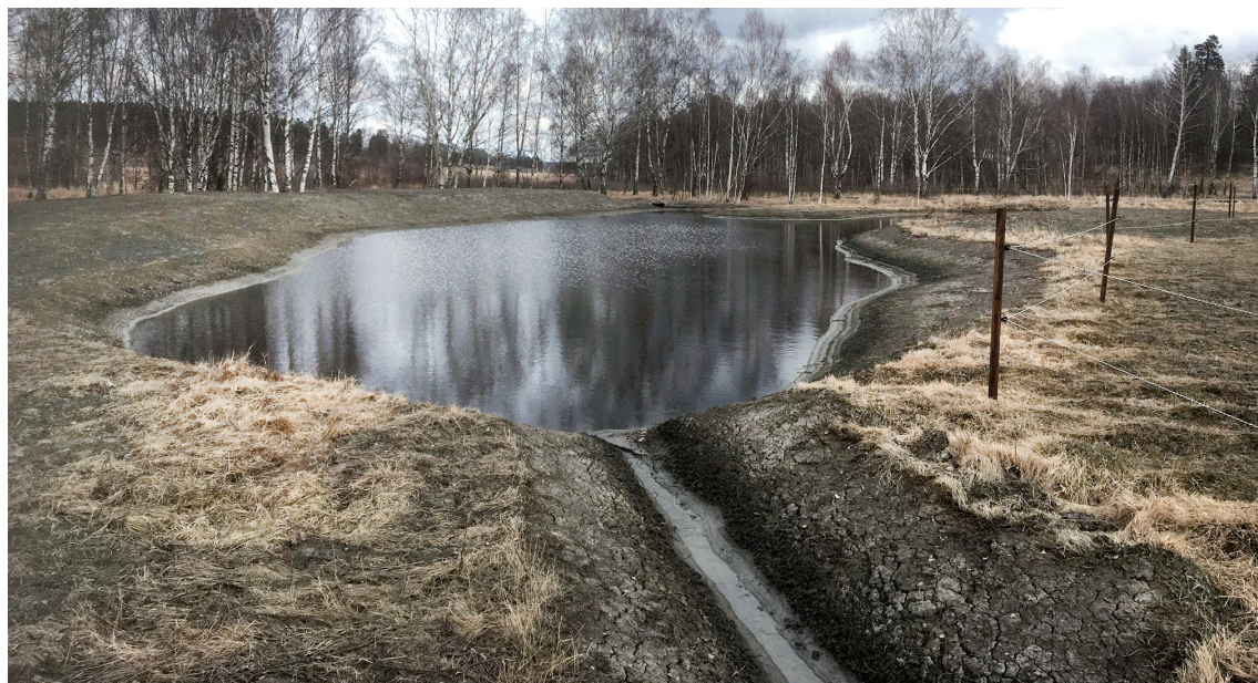
Fosfordamm på Husbyöns Islandshästgård (Foto: Sören Eriksson)
