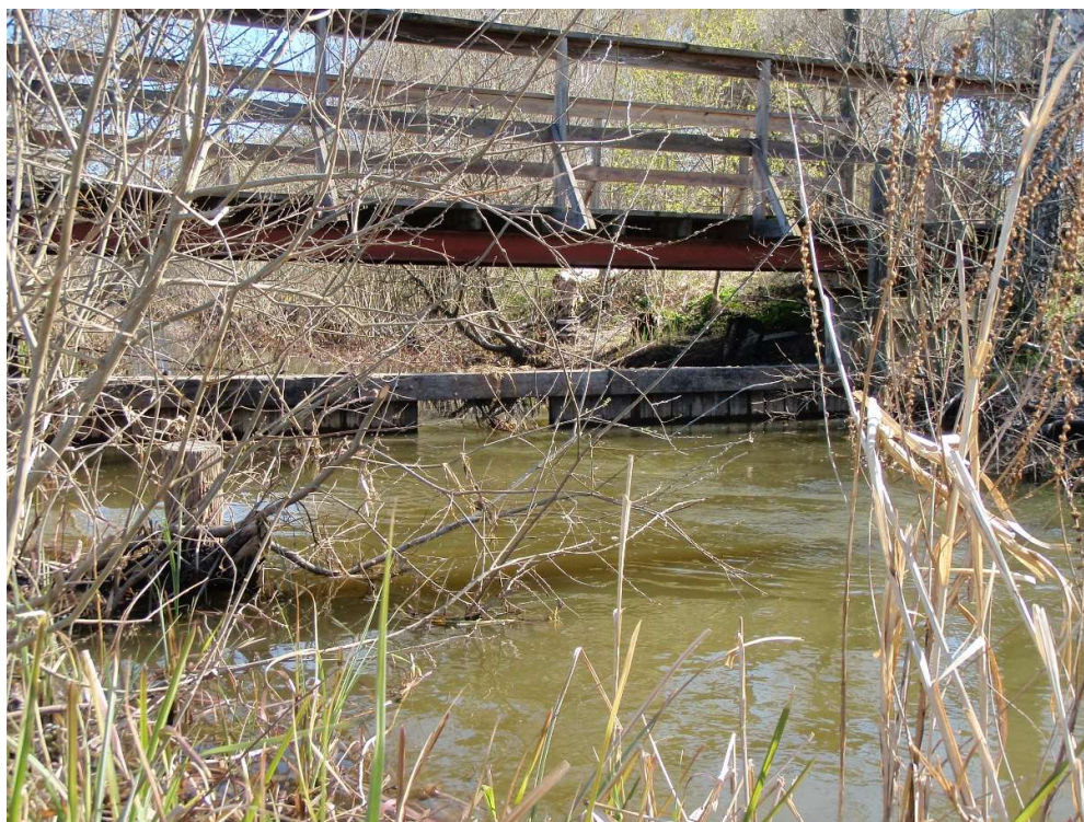
Figur 5. Hagbydämmet sett uppströms dämmet, april 2020.
