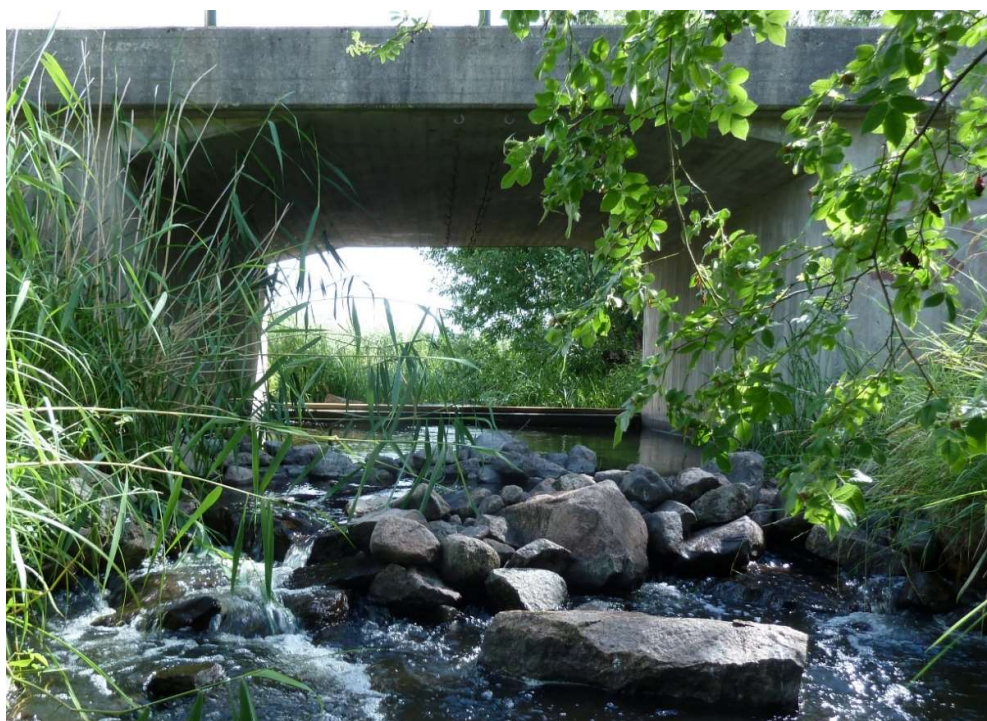
Figur 3. Fällbrodämmet i juli 2020, sett nedströms dämmet.
