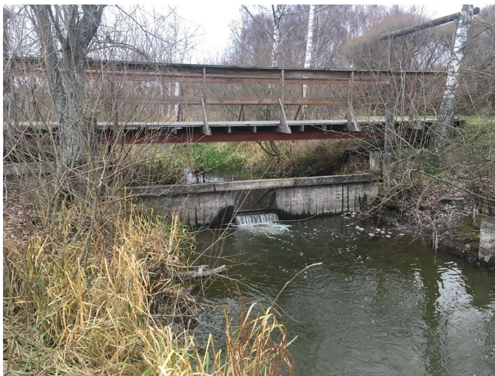
Figur 6. Hagbydämmet sett nedströms dämmet. Fotot är taget i november 2018 när vattennivån var så pass låg att man ser hela luckan i dämmet.
