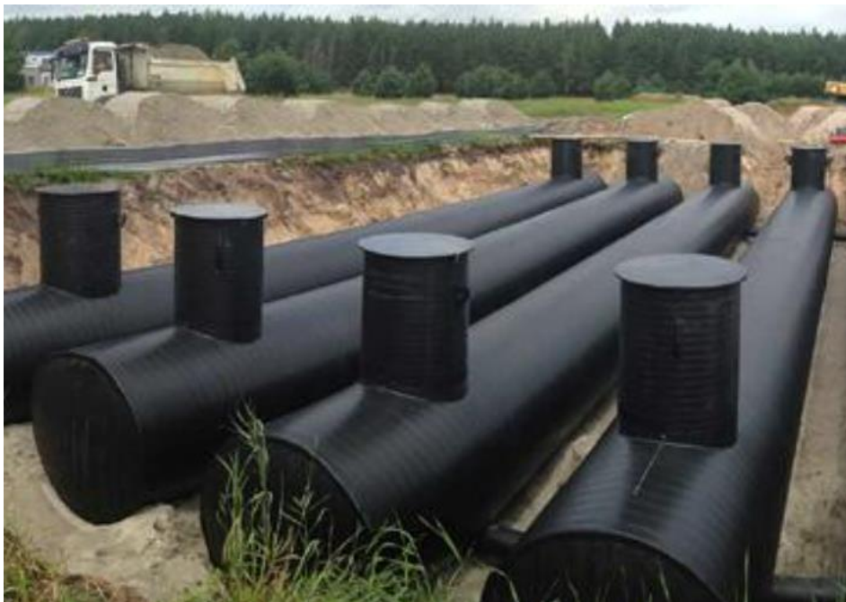
Figur 7 – Anläggning av ett rörmagasin. Bild: Uponor.
