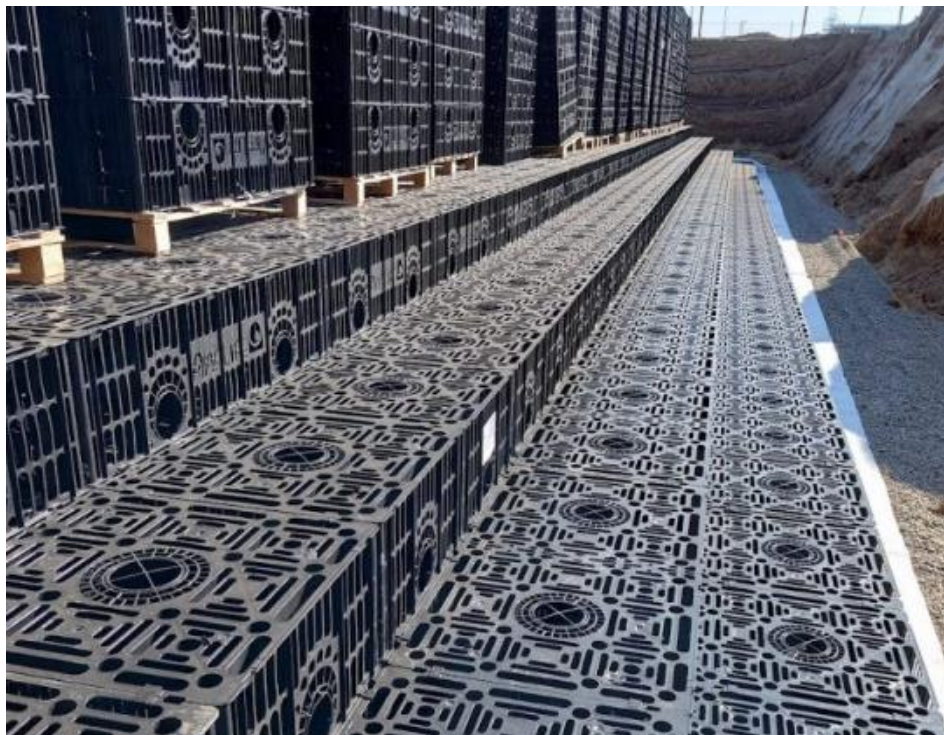
Figur 8 – Anläggning av ett kassettmagasin. Bild: Pipelife.
