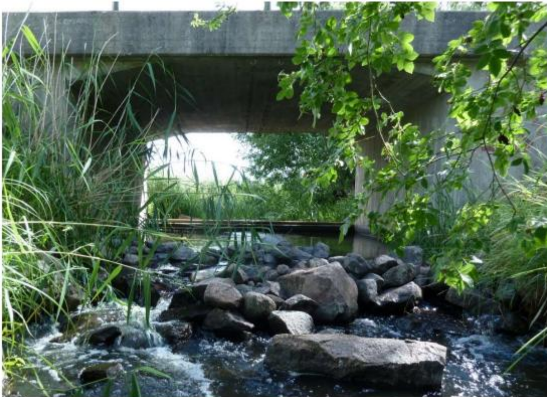
Figur 3. Fällbrodämmet i juli 2020, sett nedströms dämnet.
