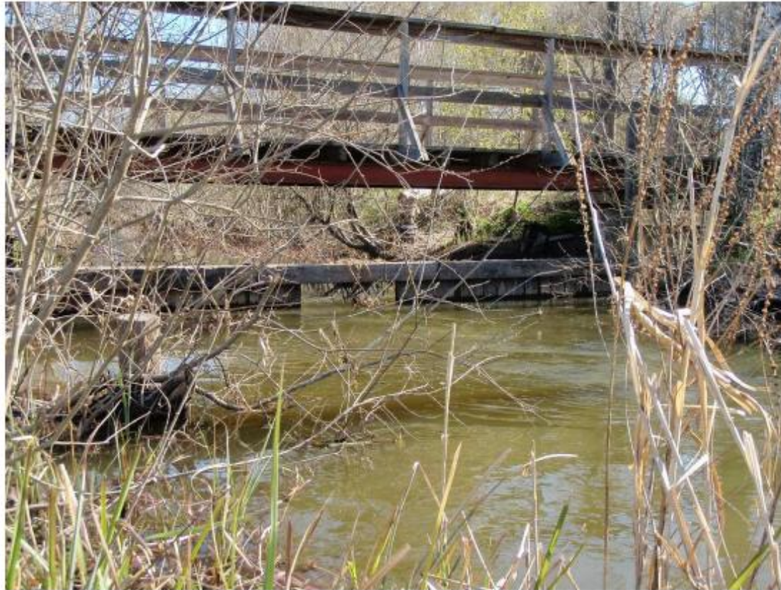
Figur 5. Hagbydämmet sett uppströms dämmet, april 2020.
