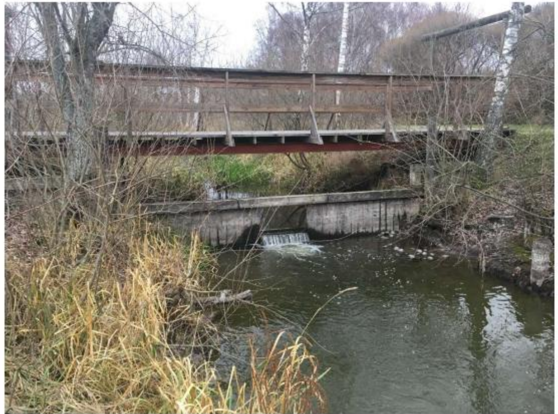
Figur 6. Hagbydämmet sett nedströms dämmet. Fotot är taget i november 2018 när vattennivån var så pass låg att man ser hela luckan i dämmet.
